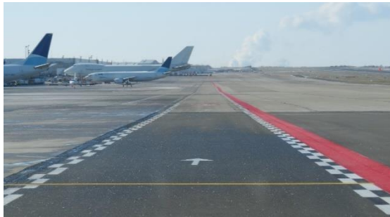
Figure 12. Voie de service arrière
