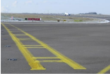
Figure 41. Marquage de point d'attente avant piste (type échelle)
