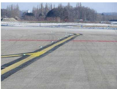
Figure 42. Ligne de guidage
